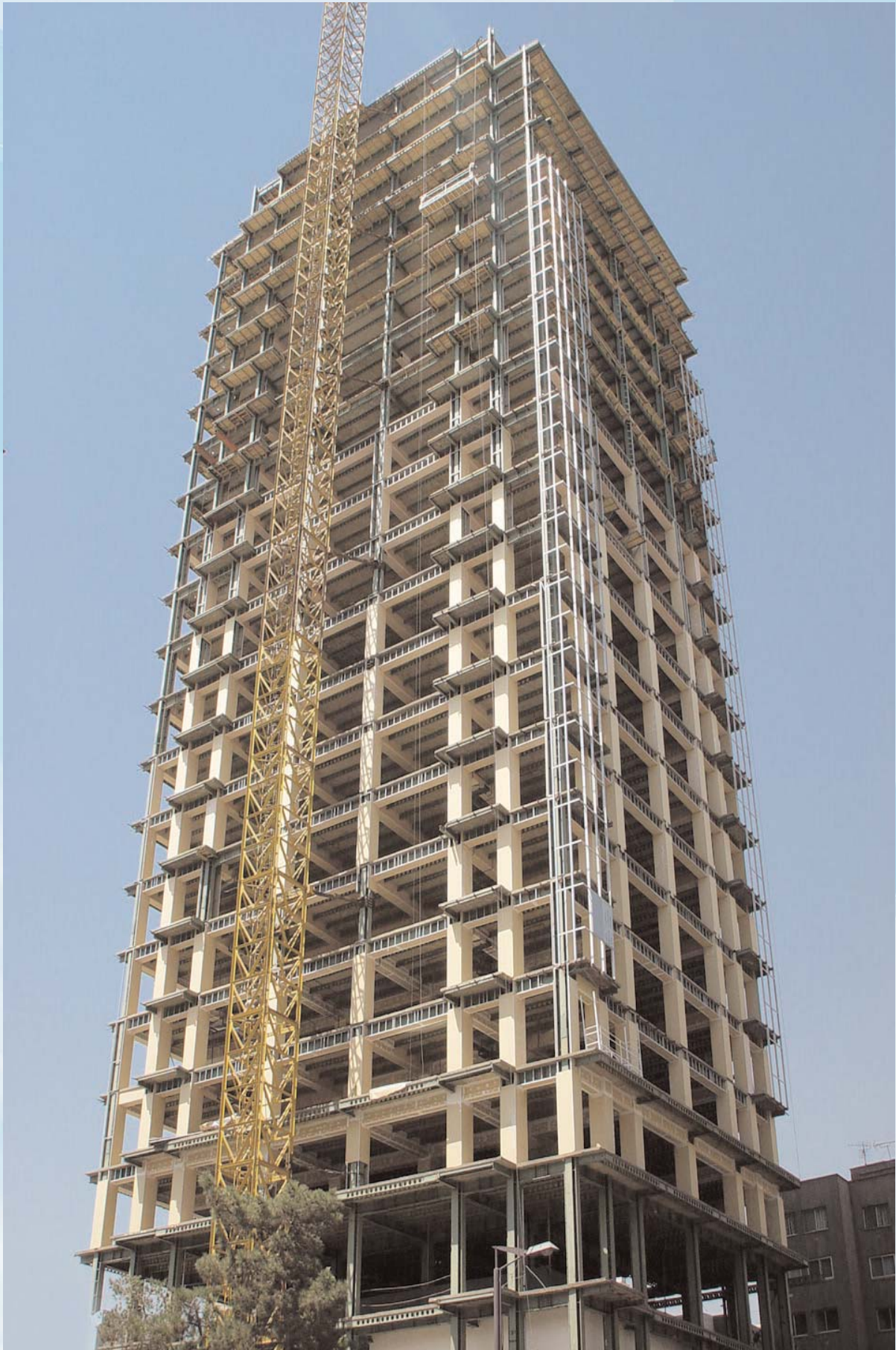
(ساختمان اداری - تهران - میدان آرژانتین) پوشش مقاوم در برابر حریق تیر و ستون
